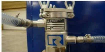
Desatornillar 3 seguros Levantar tapadera
